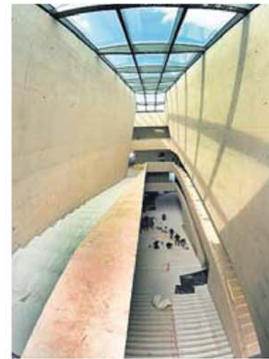
Ein Glasdach sorgt für Tageslicht im Zentralbereich des Medienzentrums.
