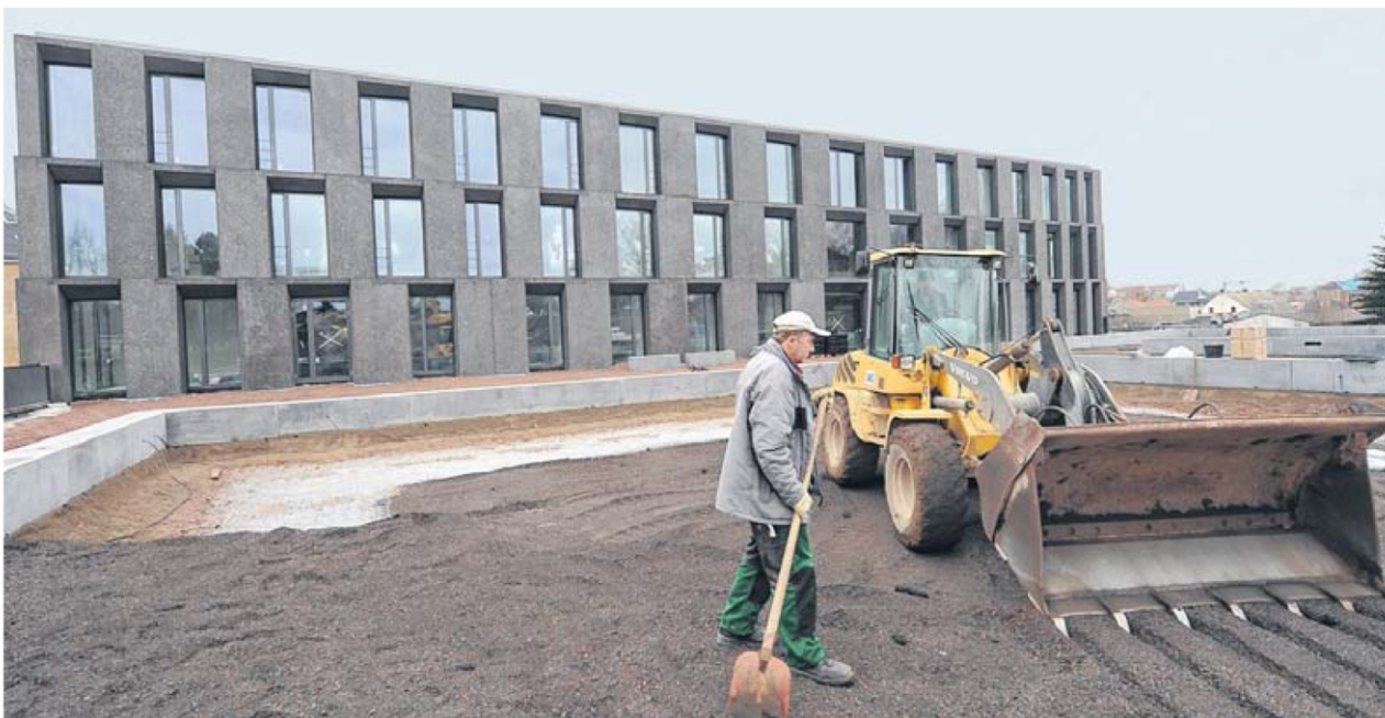
Hier sollten schon die Autos stehen: Doch derzeit laufen noch die Arbeiten am Außengelände des neuen Zentrums für Medien und Soziale Arbeit in Mittweida. So wird die Terrasse des Parkdecks mit Kies verfüllt. Später sollen dort noch Sitzbänke installiert und Bäume gepflanzt werden. FOTO: RALF HÄRTEL
