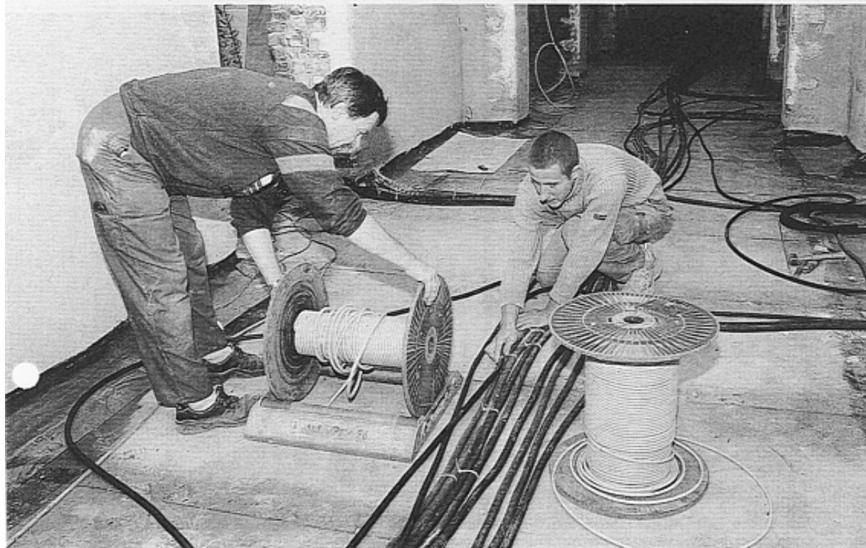
Die Elektroinstallateure Helko Pertuch (r.) und Johannes Thalmann im Untergeschoss des Hauses A, wo bis Jahresende wieder die Bibliothek des Fachbereiches Soziale Arbeit Einzug halten soll.
